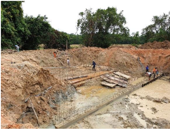
งานก่อสร้างฝายบ้านโป๊ะ ขนาดสันฝาย ยาว ๑๖.๐๐ เมตร สูง ๒.๕๐ เมตร
