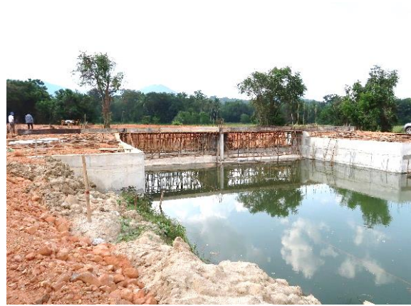
งานก่อสร้างฝายบ้านโป๊ะ ขนาดสันฝาย ยาว ๑๖.๐๐ เมตร สูง ๒.๕๐ เมตร
